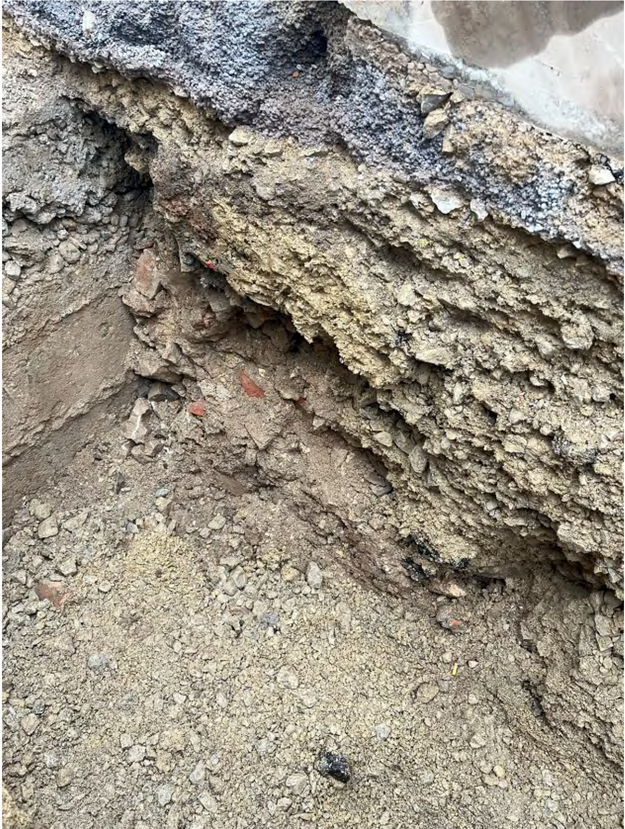
Abbildung 2 Auffüllungen hinter Mauer
