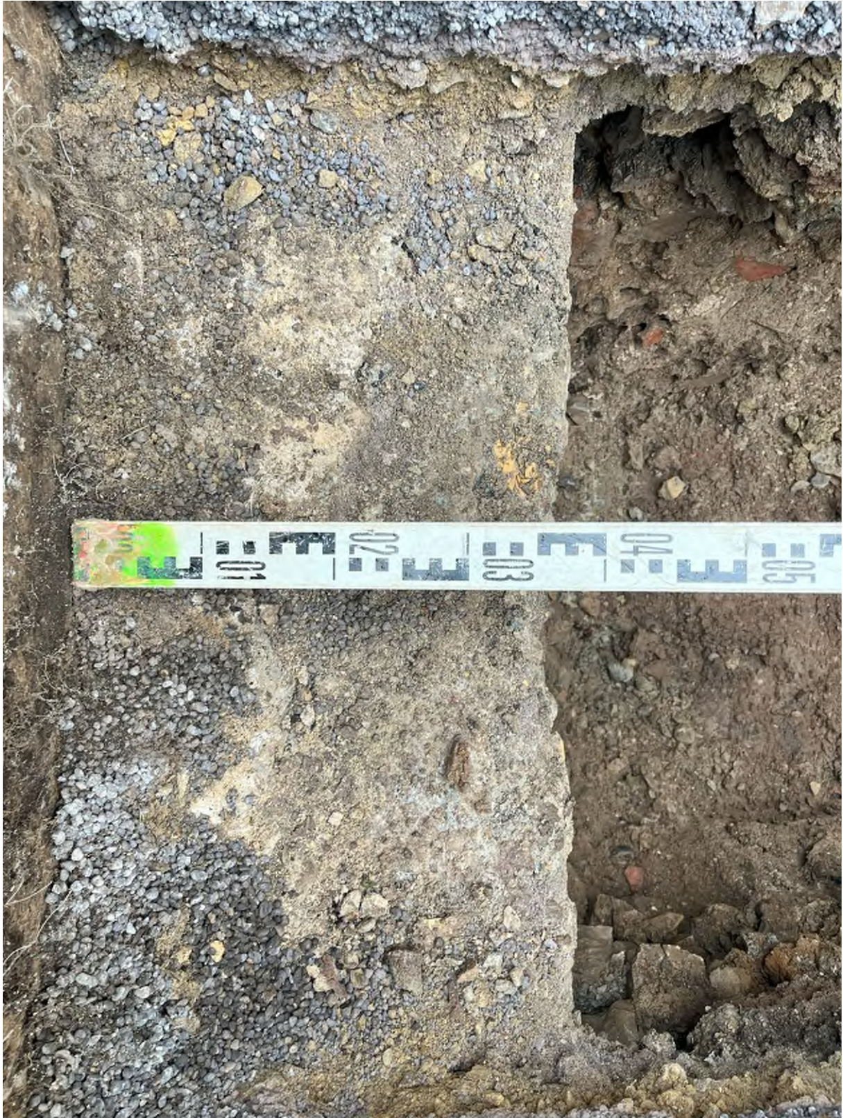
Abbildung 8 Stärke Betonfundament hinter Stadtmauer ca. 35 bis 40 cm
