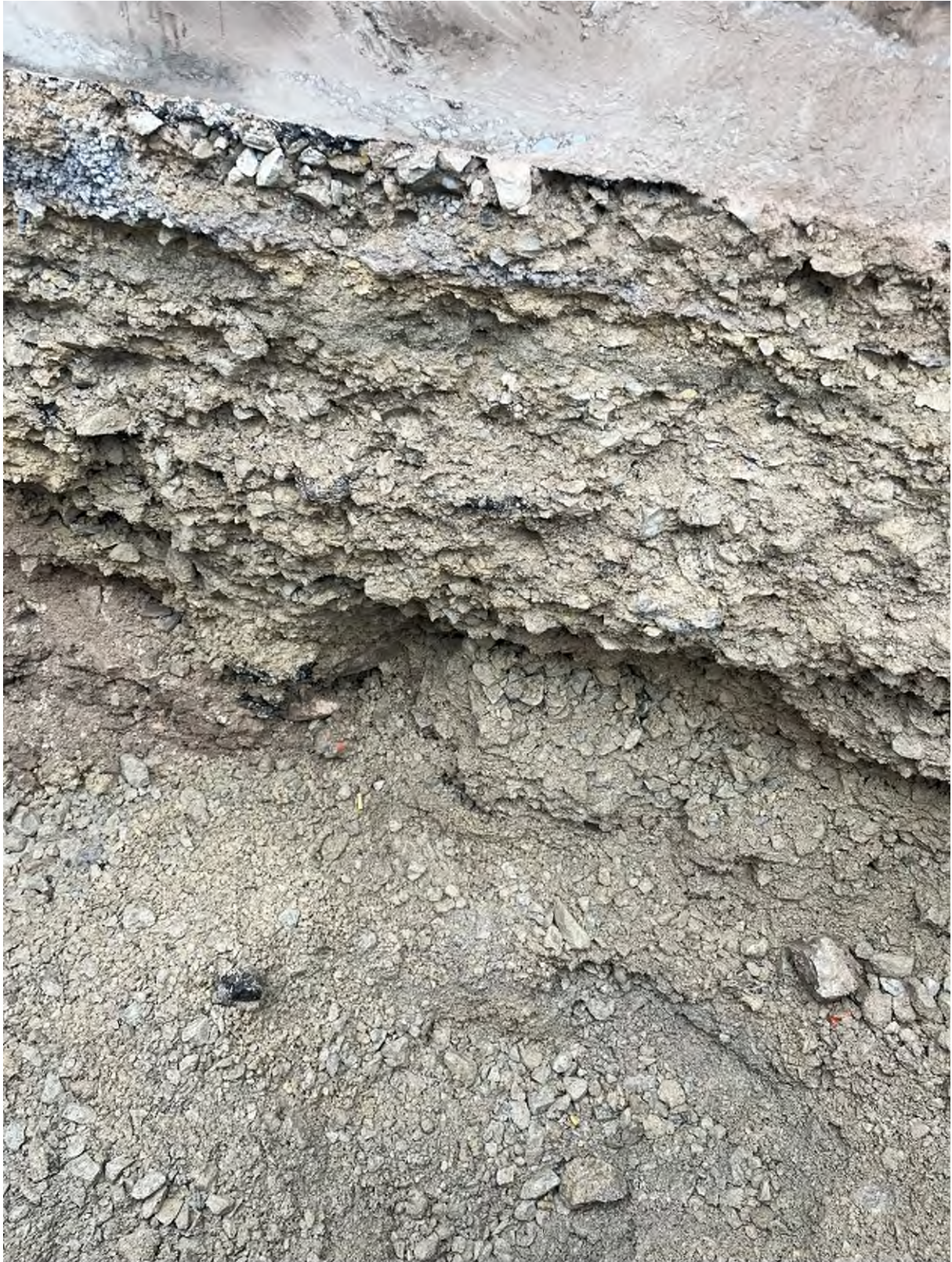
Abbildung 3 Schichtaufbau Straße
