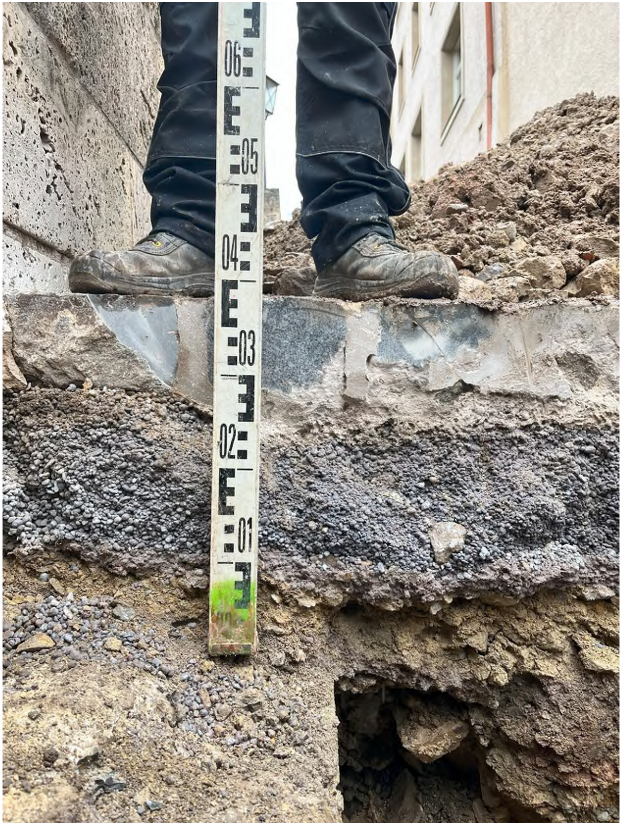
Abbildung 7 Aufbau Kopfsteinpflaster über Betonfundament Blick Richtung Westen
